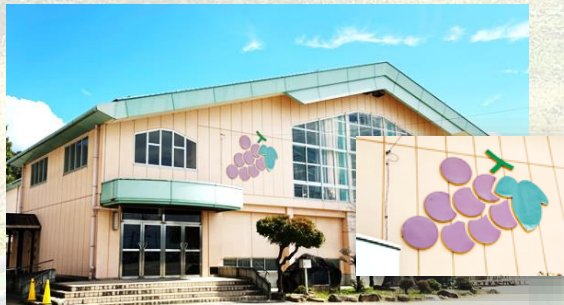
勝沼中学校 体育館外壁
