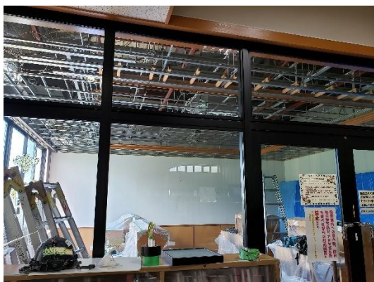
学習室の天井雨漏り修繕・勝沼図書館
